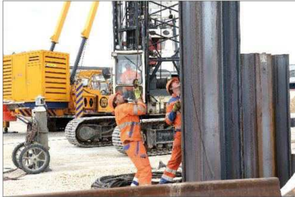
Chaque palplanche qui forme l'enceinte des fondations pèse quatre tonnes.
