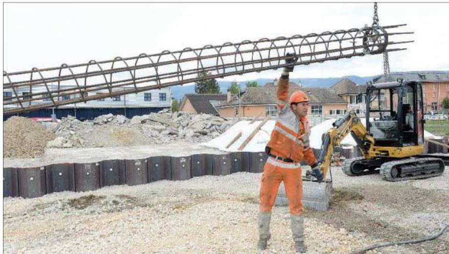
Les ouvriers de l'entreprise Marti sont habitués à couler des pieux de fondation d'une trentaine de mètres.
