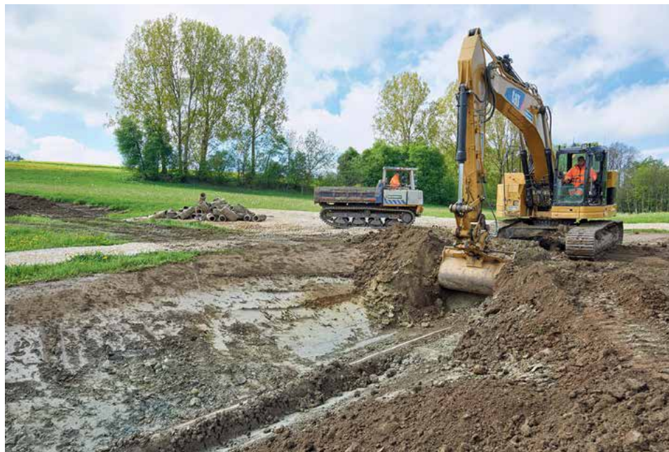
Façonnage du lit et des seuils
