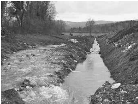
Chantier de la Morvaz : à droite l'ancien canal et à gauche le nouveau ruisseau en construction.
