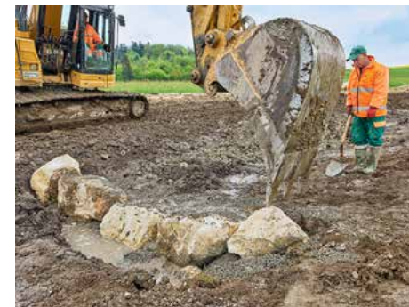
Façonnage du lit et des seuils
