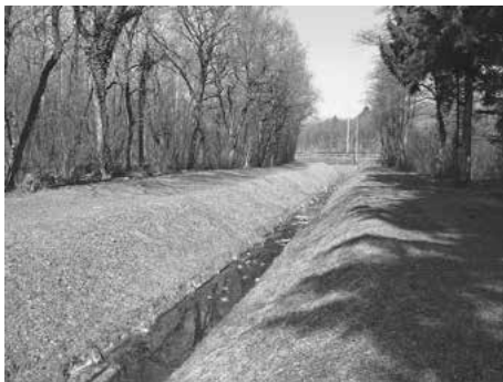
Le Creuson avant les travaux.
