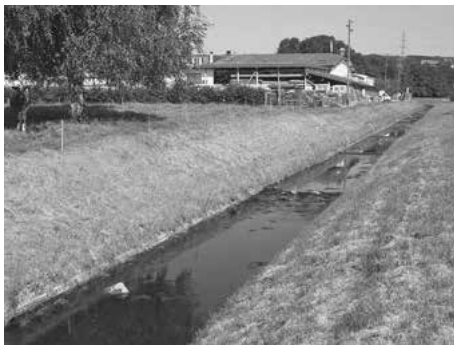
Le Grenet canalisé avant les travaux et ci-contre, un an après les travaux.
