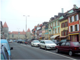
Espaces publics dominés par le stationnement (Rue des Moulins / Rue de la Plaine)
