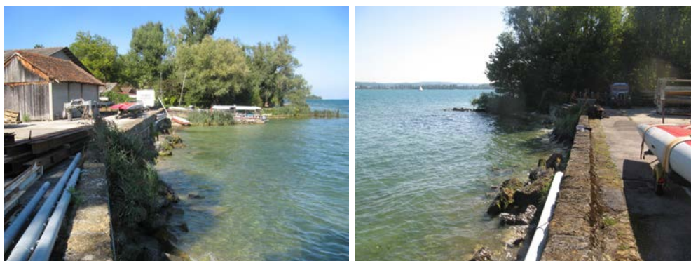
Figure 11 : Mur de soutènement des parcelles 830 et 828
